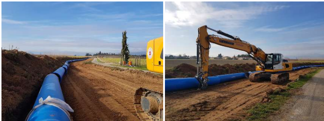
Exemple de chantier de pose (phase initiale) dans la Drôme © CAEAU
